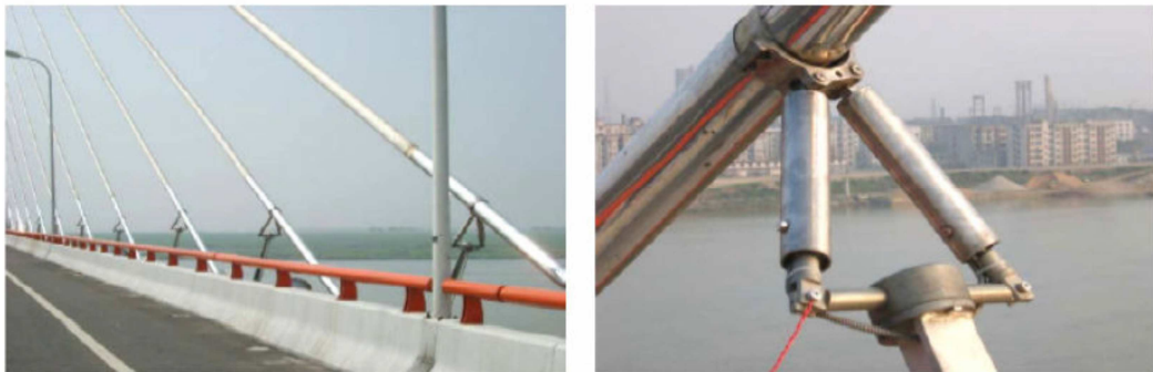
Figura 6. Amortecedores MR em cada cabo de aço da Ponte Pênsil na China (Ko et al. , 2003).
